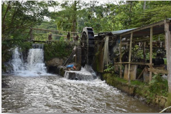
Gambar 46. Kincir air sederhana penggerak turbin Mikrohidro 2 Kwatt di TN Gunung Leuser
