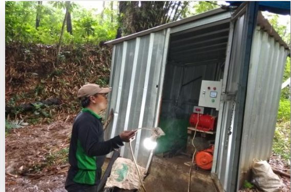
Gambar 47. Mikrohidro 2,5 Kwatt dibangun dari APBN BBKSDA Jabar di SM Gunung Sawal
